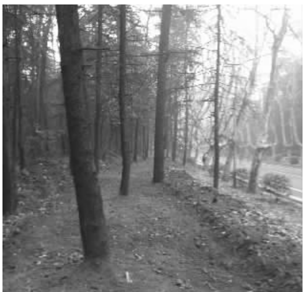
栈道工地上,绕不开的大树被留在中间
