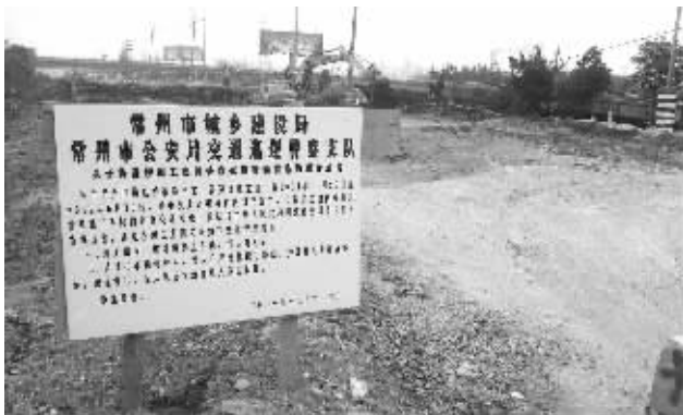
现场正在施工
