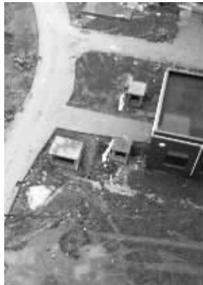
从远处配电箱拉的临时电线
