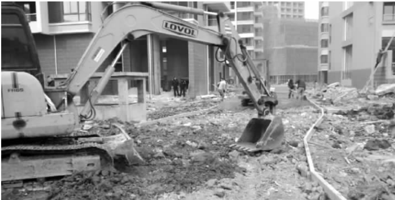
挖掘机正在拍土修路 快报记者 金辰 陈超 摄
