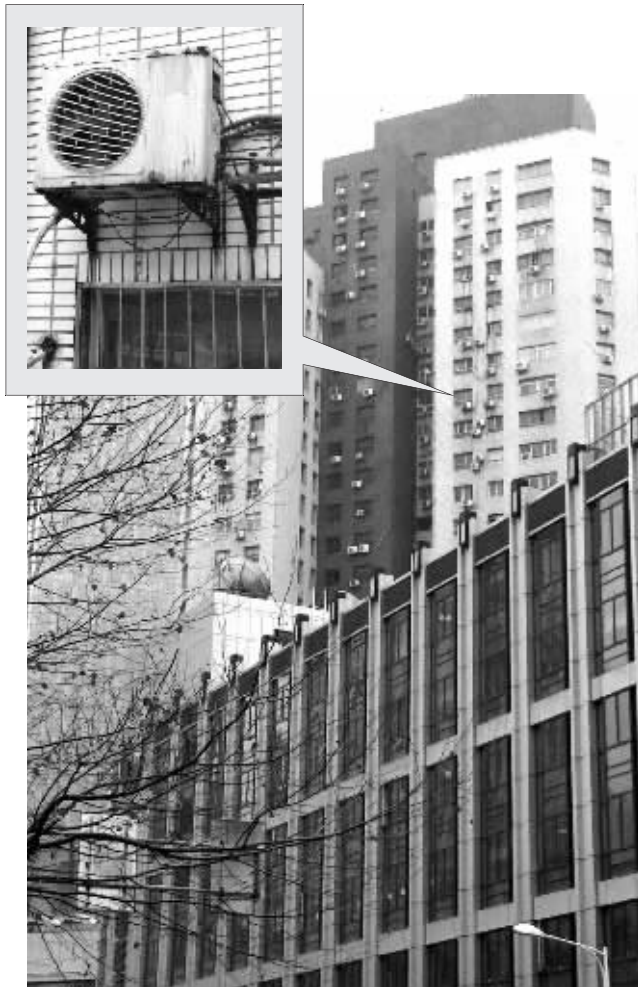
不少楼房没有专门放置空调外机的位置,靠支架固定在外墙上
