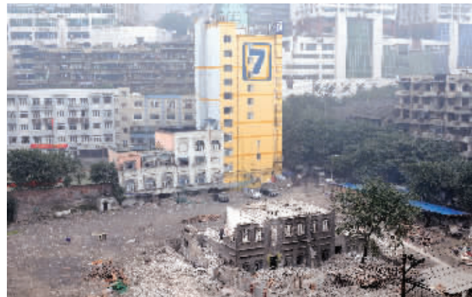
蒋介石“重庆行营”拆除施工现场及四周高楼 CFP供图
