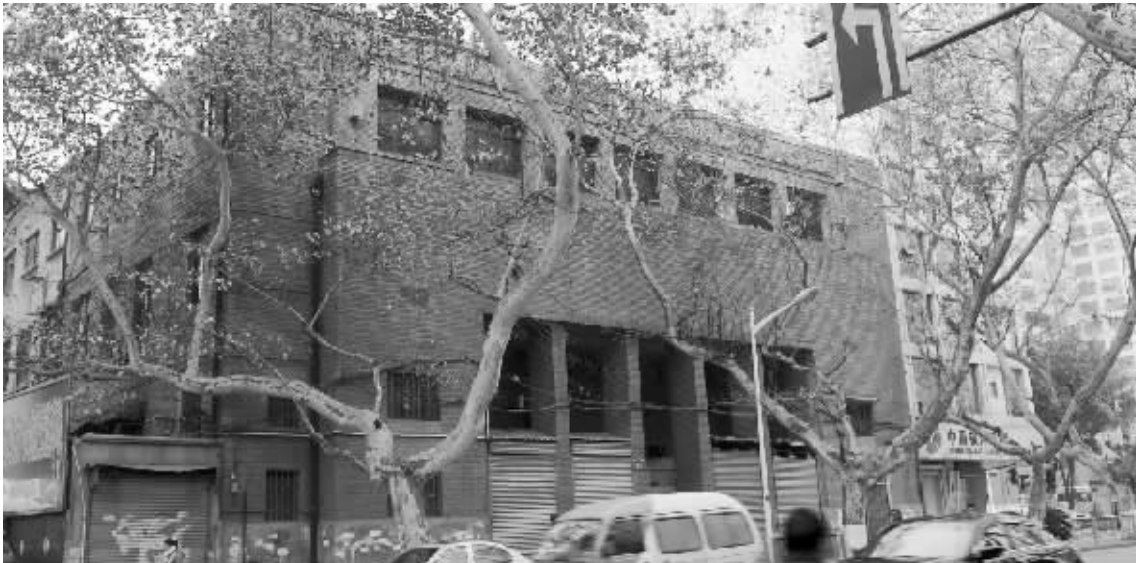
白下路23号的民国老建筑。孙中山曾将这里作为民国中央银行总部所在地
