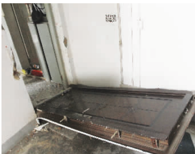
出租屋的门被炸翻倒在地上,煤气灶、抽油烟机全被震落在地,屋内一片狼藉
