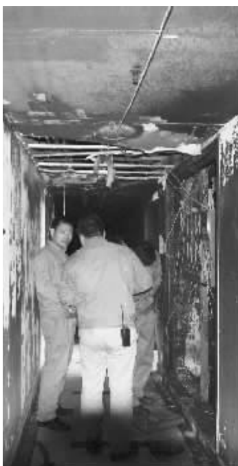
17层强电井处有工人在维修
