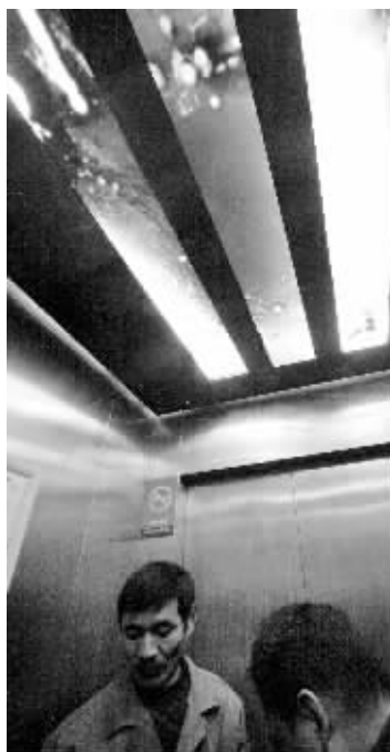
电梯上方仍有被烟熏过的痕迹
