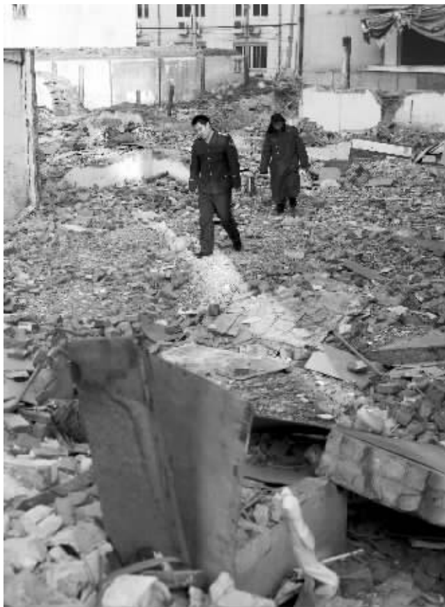
1月27日,保安走在梁思成林徽因故居的废墟上 新华社记者 沈伯韩 摄
