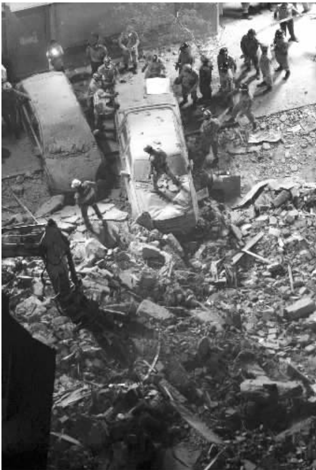
救援人员在坍塌现场
