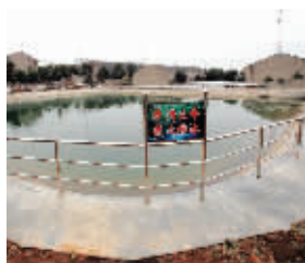
仓库设有消防塘,池塘3米多深,可持续供水30个小时 快报记者 路军 摄
