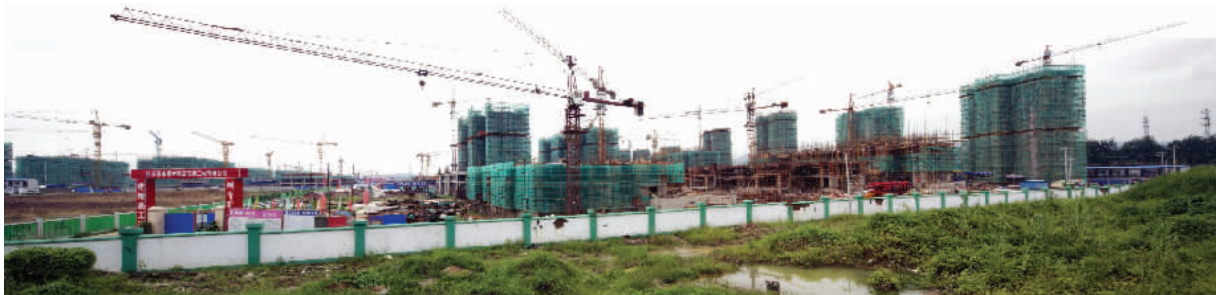
南京保障房项目——幸福城居住区建设工程地 快报记者 路军 摄
