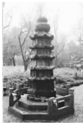
对照上图，原塔尖部分掉落
