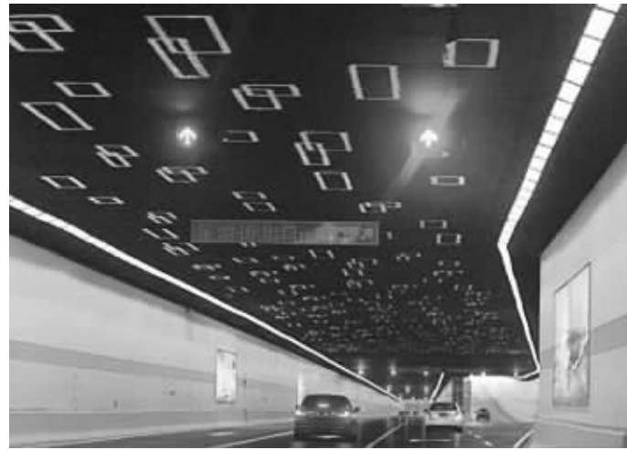
独墅湖隧桥工程全长7.37公里,其中隧道部分长3.46公里 资料图片
