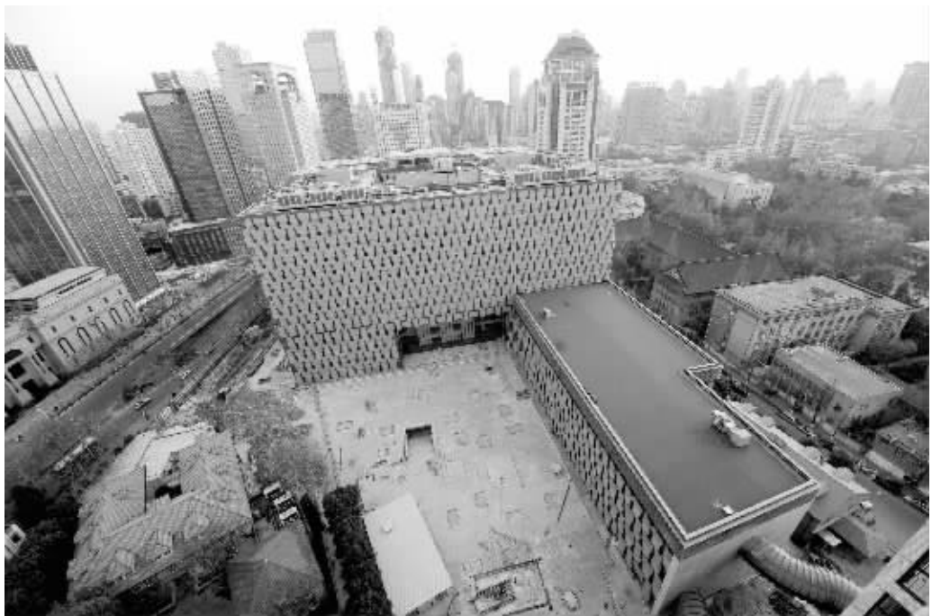
正在装修中的鼓楼医院南扩工程新大楼外景
