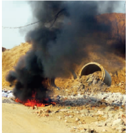
离南京南站东南侧500余米的工地上,经常有人焚烧建筑垃圾。1月3日我路过这里,发现一堆垃圾正在燃烧,上空就是通讯电缆,万一烧断了,就出大麻烦了。1月3日摄于南京南站东南侧工地 (作者琢如获30元话费)
