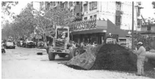
福园街施工，3条公交临时改线
