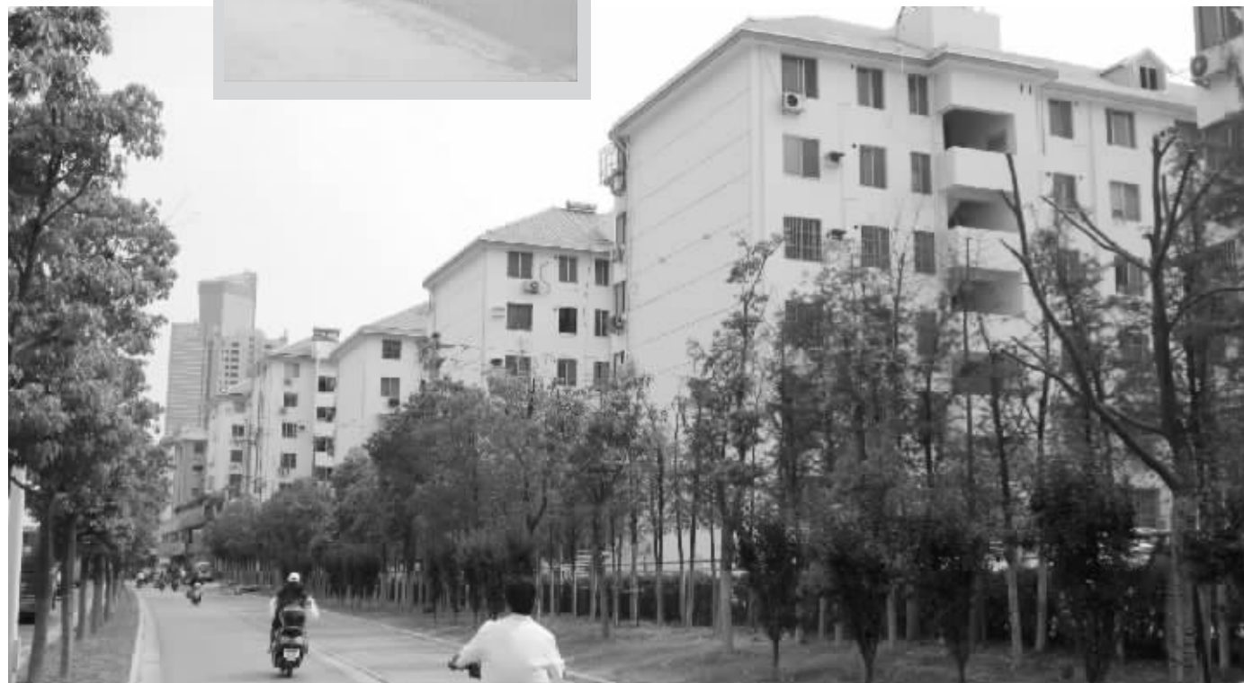
快速内环惠山隧道口至建筑路段(28幢59个门号)的旧住宅楼实施“平改坡”后旧貌换新颜 滨湖区住房保障和房产管理局供图
