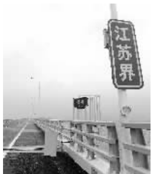
崇启大桥上的江苏界牌 快报记者 施向辉 摄
