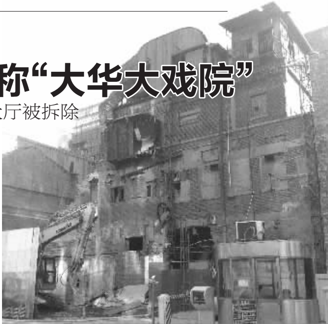
大华电影院部分大厅被拆除
