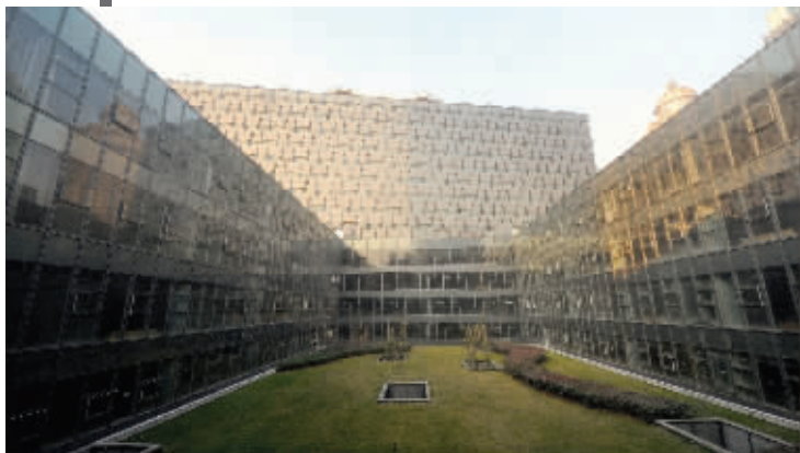
正在建设中的新大楼花园
