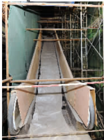
大楼里的电梯
