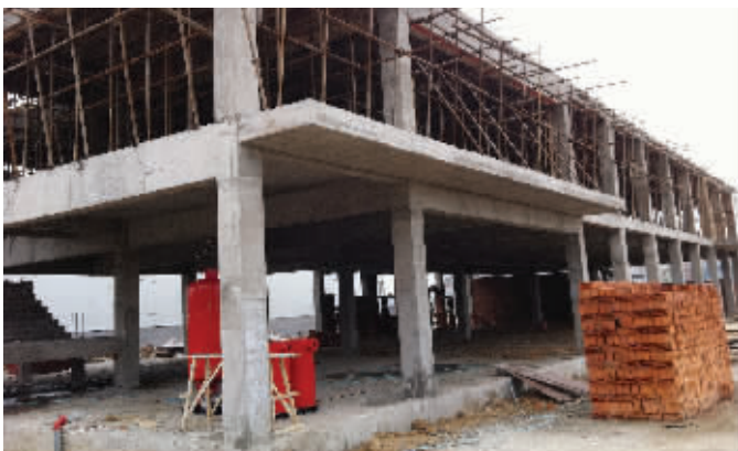
在建的汽车销售公司办公楼
