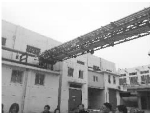
排污管道架到空中,冷浸港由此变得清洁起来
