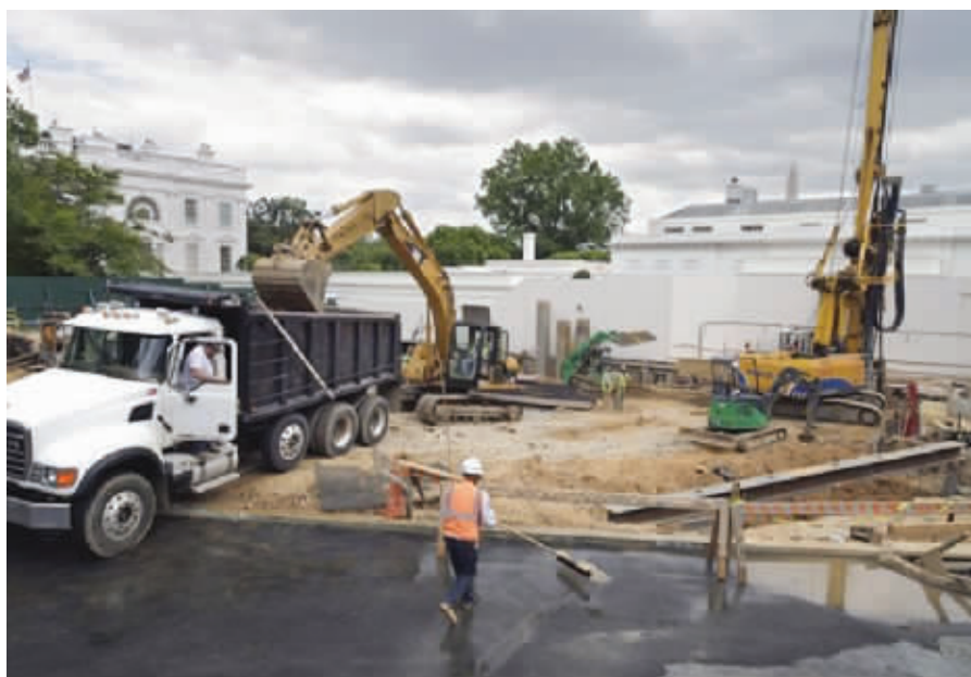
白宫施工现场
