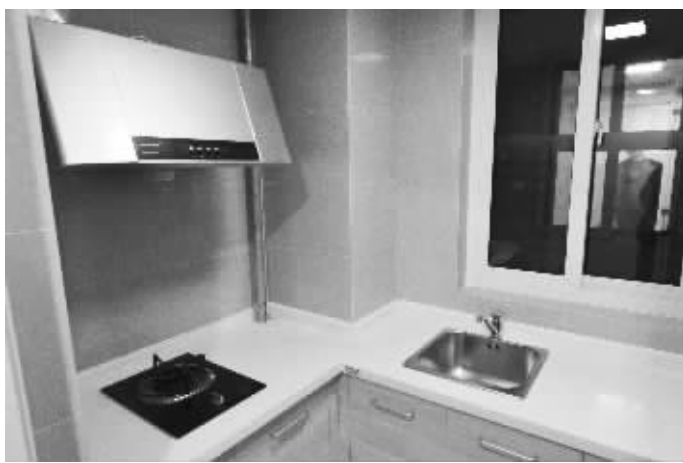
油烟机和灶具等已经安装到位 陈焯摄
