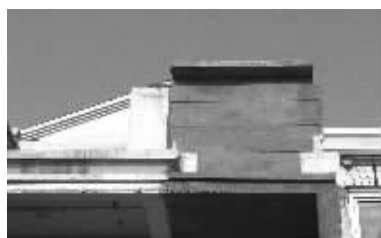
楼顶盖间“储藏室”
