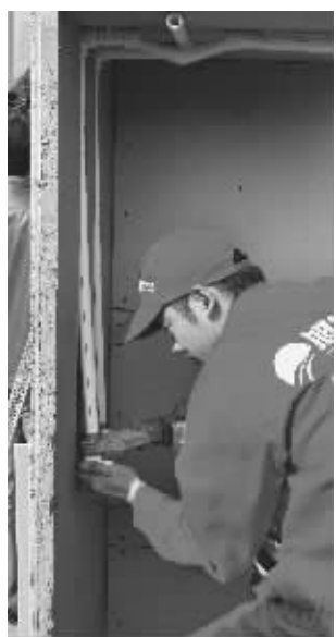
一名工人在比赛现场铺设管道
