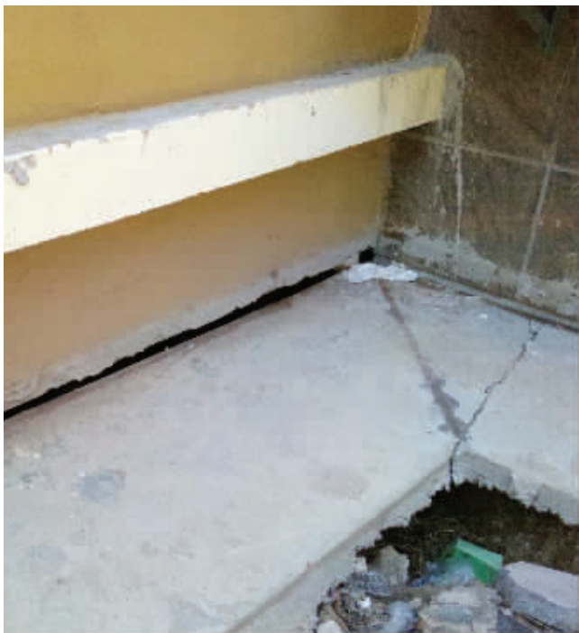
除墙面裂纹外,业主发现地基也在沉降
