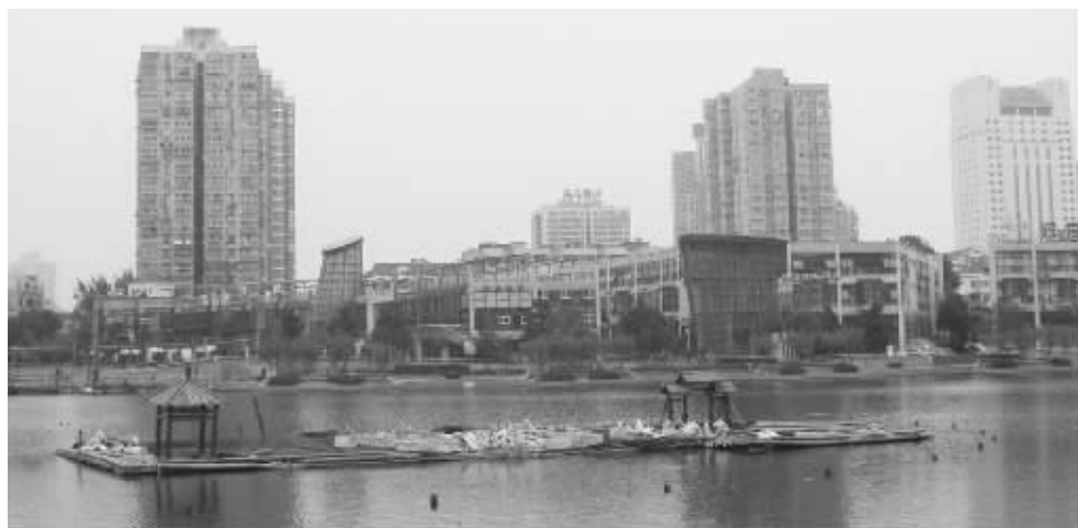
正在建设中的南湖水景平台
