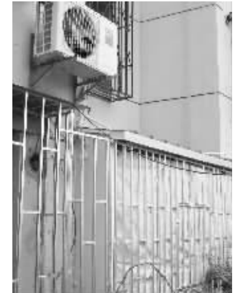
一楼搭建的铁皮屋
