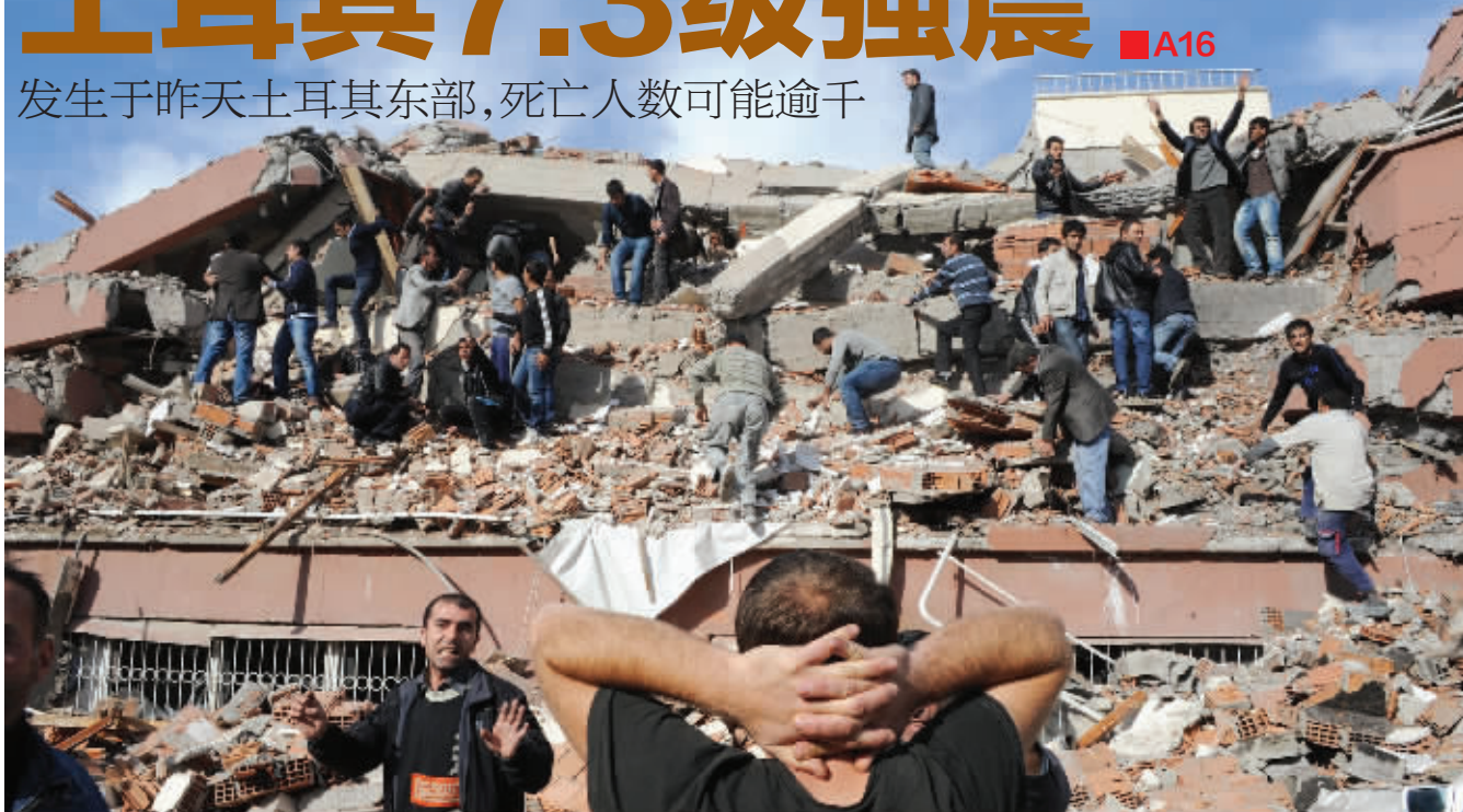
据中国国家地震台网测定，北京时间10月23日18时41分，土耳其东部(北纬38.8度、东经43.5度)发生7.3级地震，震源深度约10公里。图为在土耳其东部凡省，当地居民在震后废墟中搜救
