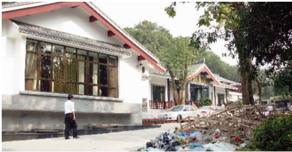
高档会所的门口堆满了垃圾
