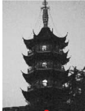
10月13日 夜幕中重建完工的药师佛塔 快报记者 赵杰 摄
