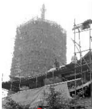
9月8日 药师佛塔重建现场
