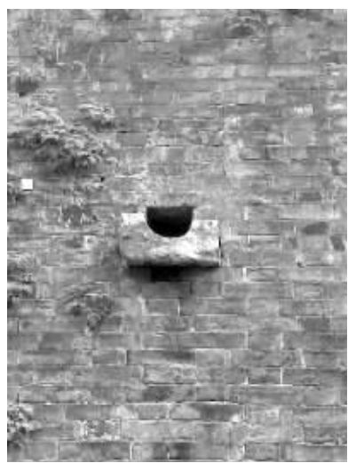
PVC管已拆除,留下原来的排水口
