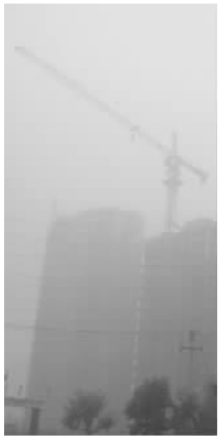
工地扬尘是空气污染元凶之一 资料图片
