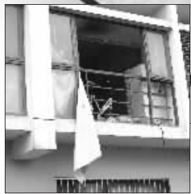
阳台上两扇窗户飞出十几米远, 窗框向外凸出变形
