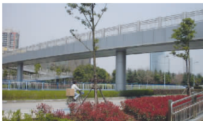
无锡过街天桥超过10座,美中不足的是没一座有名字 资料图片
