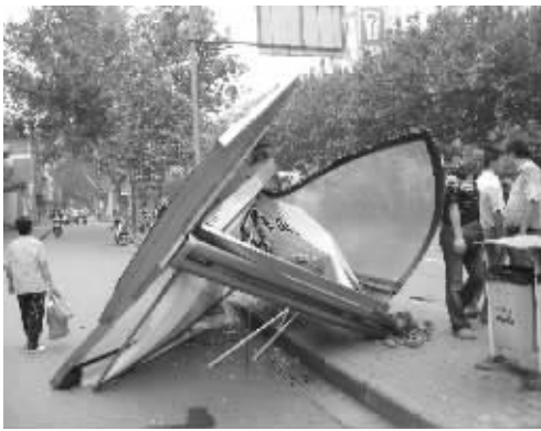
站台上的广告灯箱已经倾斜
