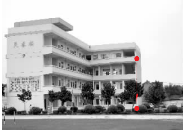
综合楼4楼走廊尽头有个缺口,刘婷很可能就是从那里坠落
