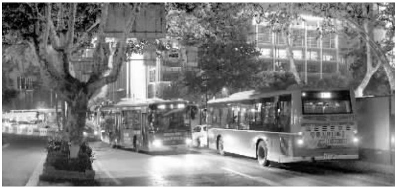
太平南路中山东路十字路口围挡施工,公交车通行困难 本版摄影 快报记者 路军
