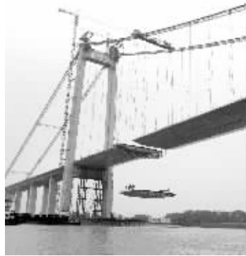
钢梁箱吊装作业正在进行
