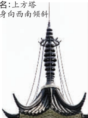
楞伽寺塔塔刹被还原,塔高增加2.68米
