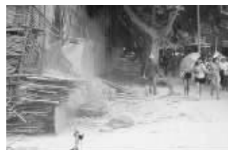
拆楼现场，尘土飞扬
