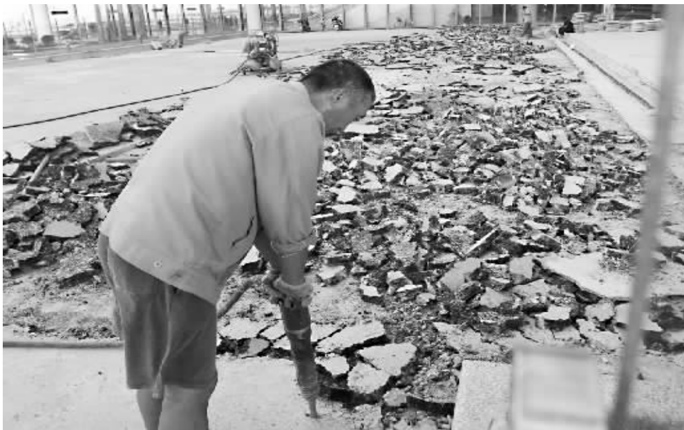
南京南站二楼东侧平台地面被凿开重铺 快报记者 路军 摄
