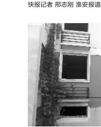
虽已封顶,但门窗尚未安装
