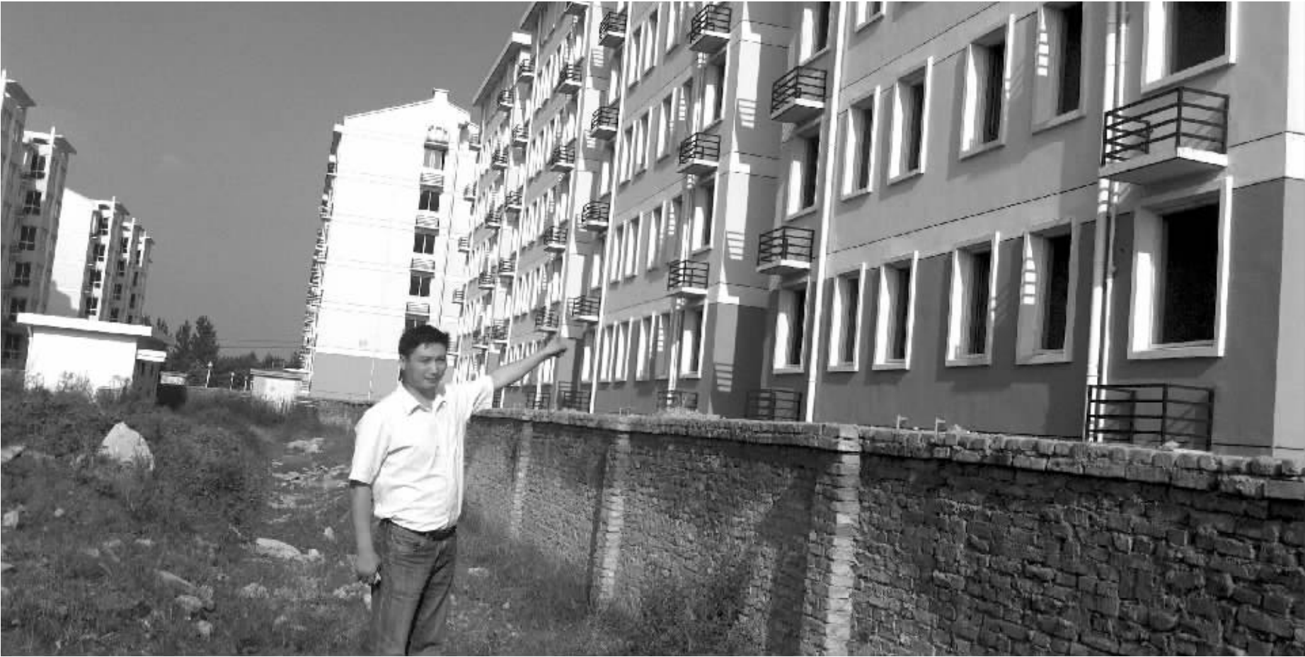
只剩扫尾工程的安置房已被法院实施保全,村民们只能“望房兴叹” 本版摄影 快报记者 邢志刚
