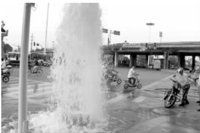
大桥饭店门口,被撞断的消防栓喷出水柱 (报料人张先生供图)
