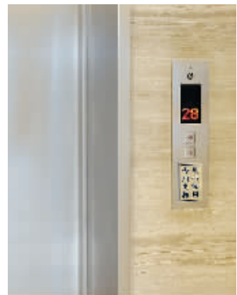
“专用电梯”需刷卡使用
