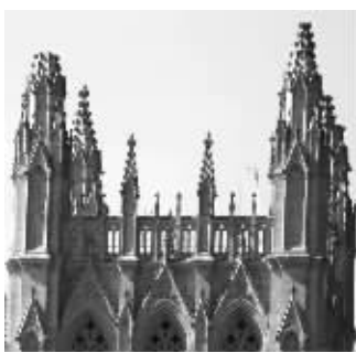
国家大教堂塔楼左边塔尖掉了
