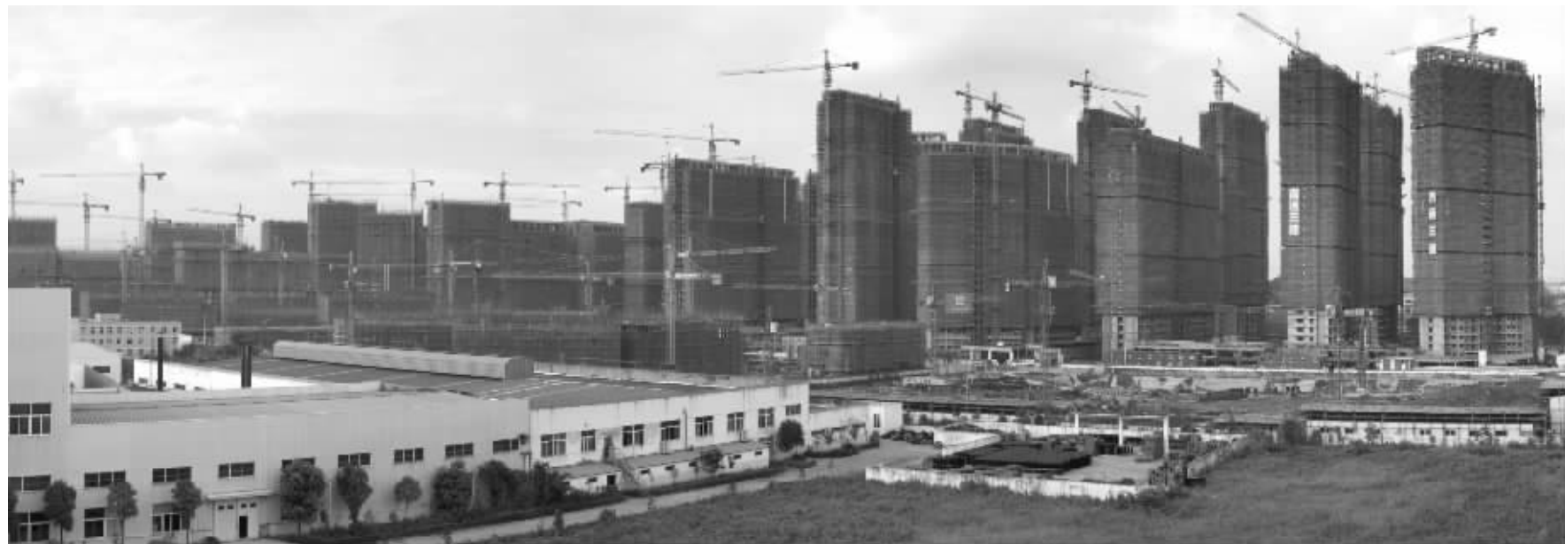
南京保障房建设紧锣密鼓，图为汇杰新城项目
