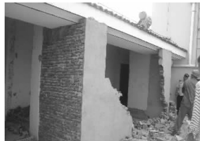
拆违工人正在拆除一处违建 城管供图
