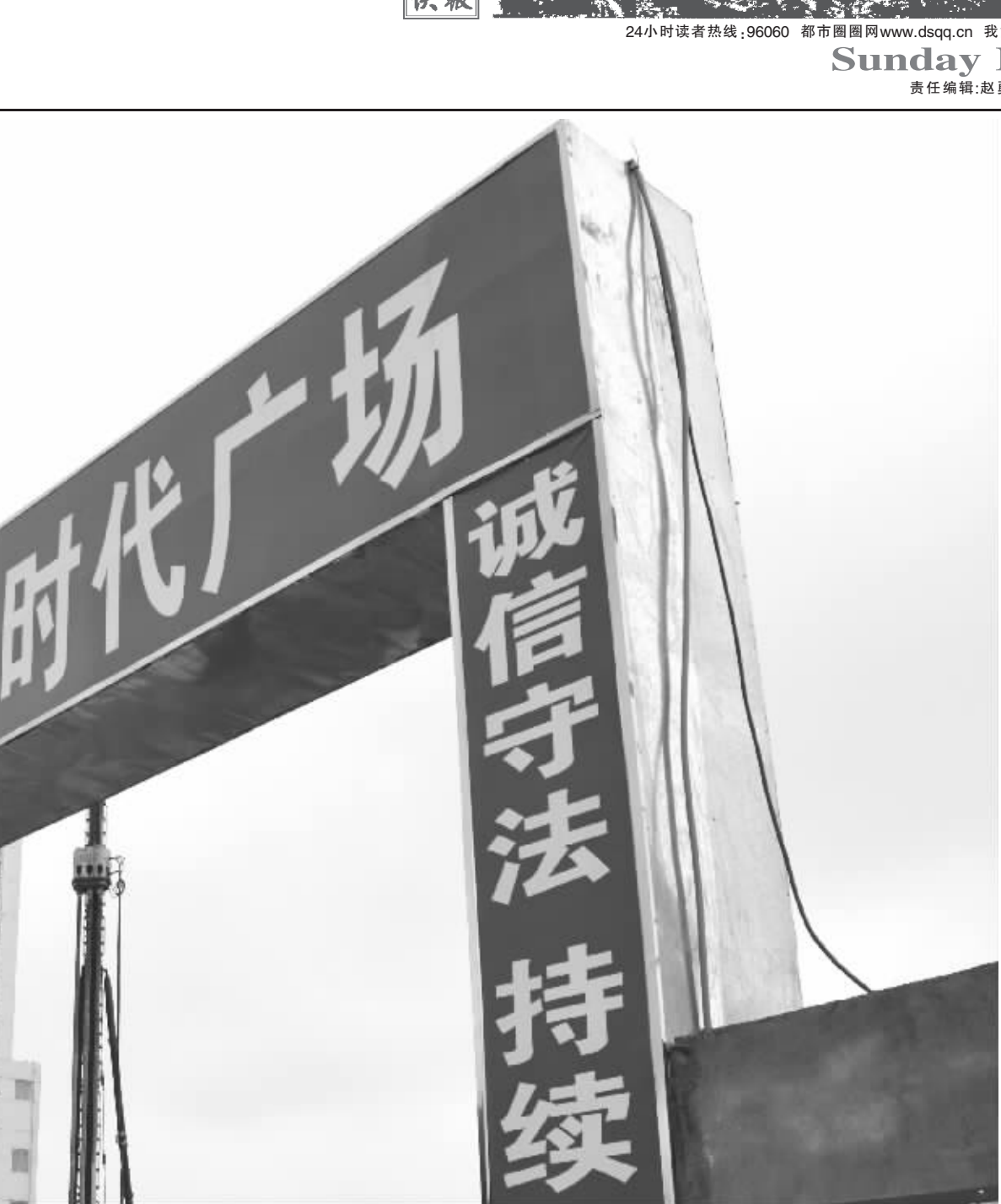
作为备受瞩目的地标建筑,茂业时代广场的建设速度如何,一度被一些领导说成“影响淮安城市形象”
