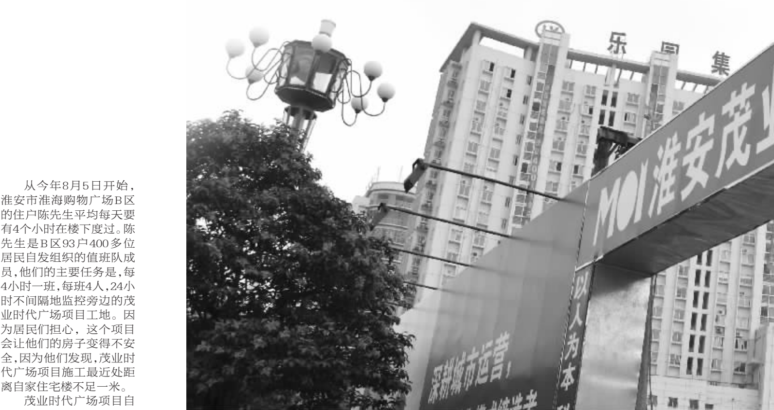
作为备受瞩目的地标建筑,茂业时代广场的建设速度如何,一度被一些领导说成“影响淮安城市形象”
