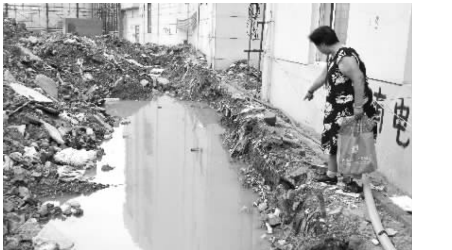
茂业时代广场施工所挖深沟,与旁边的居民楼近在咫尺,这令居民们很担心自家房子的安危
